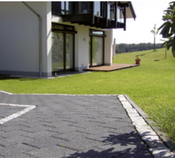
**Hinweis:** Aus Gründen des Grundwasserschutzes und der Frost-Tausalz-Widerstandsfähigkeit ist DRAIN-RECHTECK nicht für Flächen geeignet, auf denen die Anwendung von Taumitteln erfolgt. Auch auf nur gelegentlich befahrenen Flächen\*, kann es durch Taumittelreste vom Fahrzeug zu Beschädigungen der Steine kommen.
